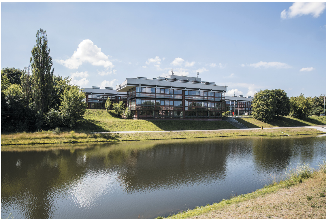
02.07.2015, widok na budynek ASP
